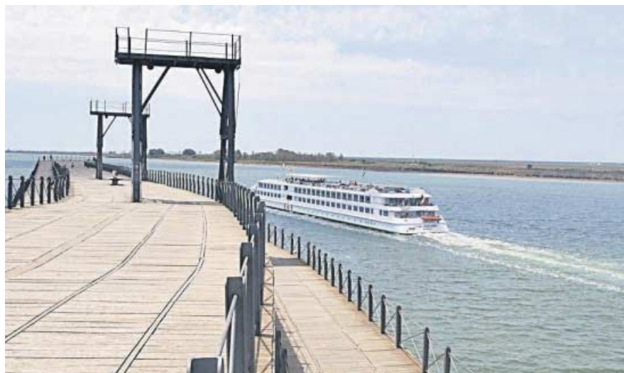
Cargadero de Río Tinto, del puerto onubense.
