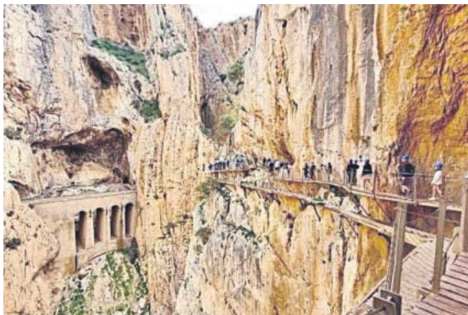
Pasarela del Caminito del Rey en Málaga.
